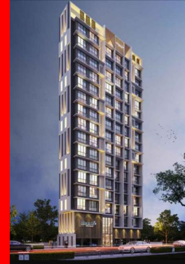
Dattani Nagar Bldg.no.04 Borivali West
